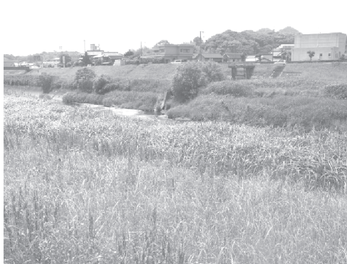
図 1 - d 鶴三緒ポンプ場前その 1
